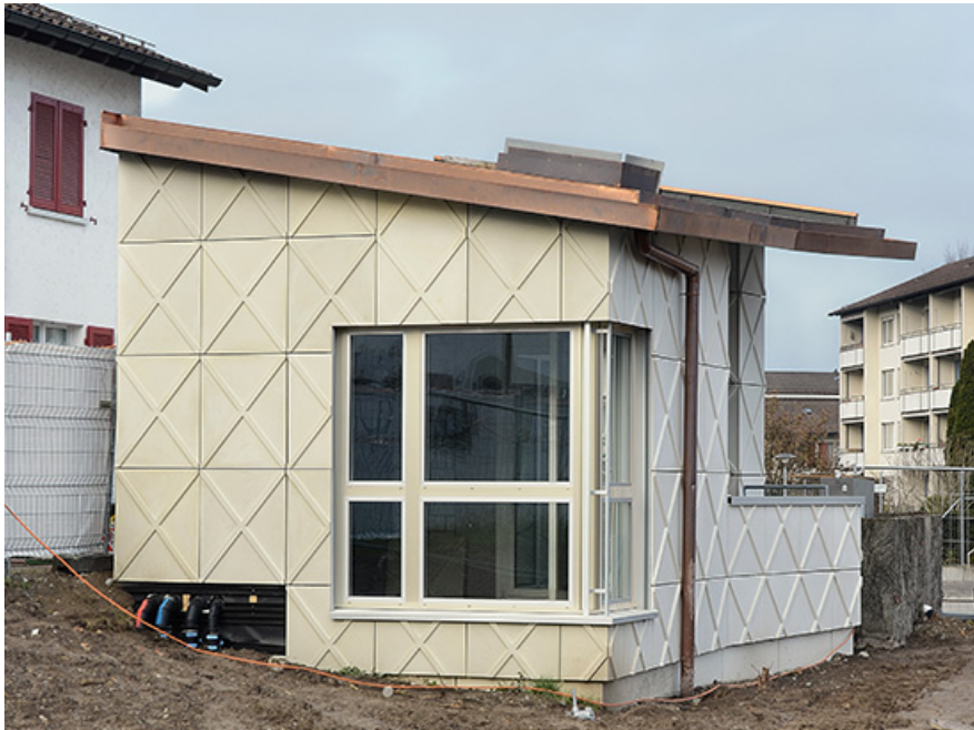
Mock-Up Fassade und Dach der Wohnsiedlung Schwamendinger-Dreieck, BS+EMI Architektenpartner AG
