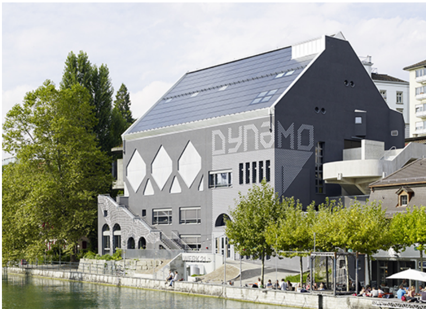
Photovoltaik-System Integral 2, Dynamo, Zürich, Kaufmann Widrig Architekten GmbH, 2015
