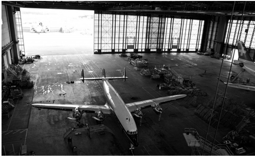
Glasfaserkunststofffassade im grossen Massstab: Werft 3 der SR Technics, Flughafen Zürich
