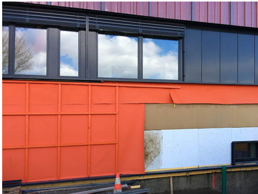
Fassadenaufbau mit Unterkonstruktion und Scobalit Platten
